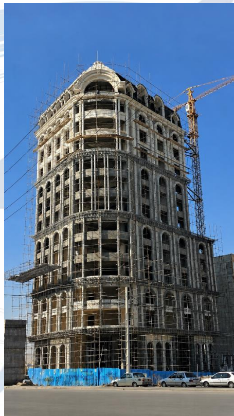
پروژه برج فرشته
